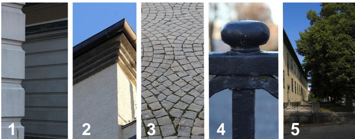
Detaljbilder: 1. Tingshusets rusticerade sockel. 2. Takfoten på Sparbankshuset och den slammade fasaden. 3. Torgets mönsterlagda gatsten. 4. Räcke av järn vid Sparbankshuset. 5. Sparbankshuset förträdgård. Bildkälla: Bild 1-4 foto Tyréns AB. Bild 5 Foto Bergslagens Miljö- och Byggförvaltning.
