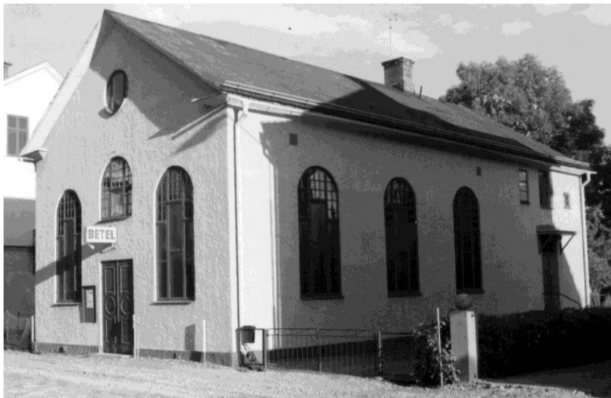
Foto överst: Folkets hus med bar tegelstomme innan byggnaden putsades 1924. Bildkälla: Lindesbergs kulturhistoriska arkiv. Foto ovan: Betelkyrkan uppförd 1906 med tidstypiskt formspråk och detaljer. Bildkälla: Lindesbergs kulturhistoriska arkiv.
